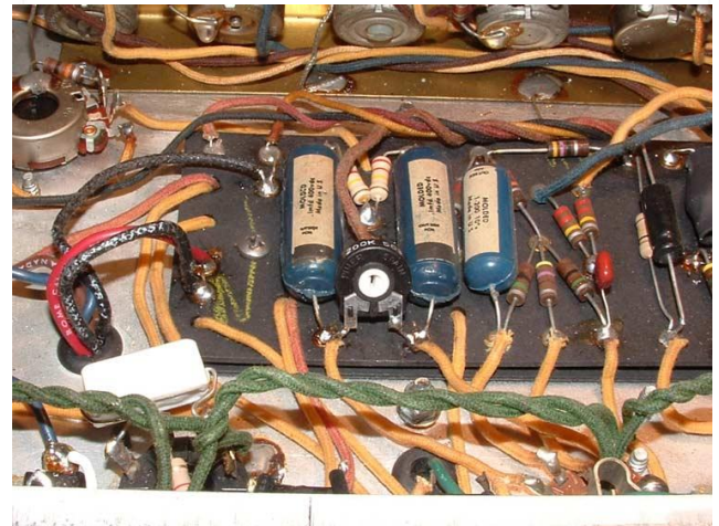
شکل ۱-۵ - نصب قطعات الکترونیکی در دستگاه های قدیمی
