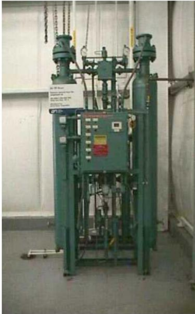
شکل ۴۴- نمونه ای از یک نوع خشک کن
