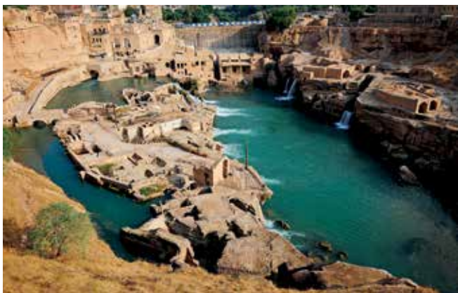
Storico complesso idraulico di Shushtar - Khuzestan
