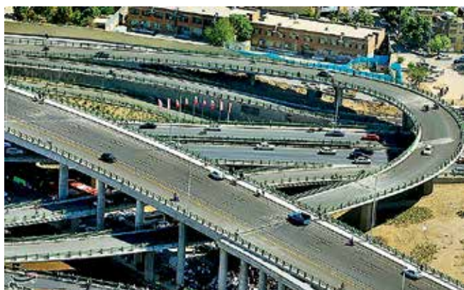
Infrastrutture urbanistiche – autostrada “Imam Ali”
