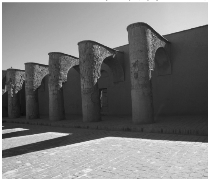
تصویر شماره (۴): رواق ضلع شرقی مسجد تاریخانه
