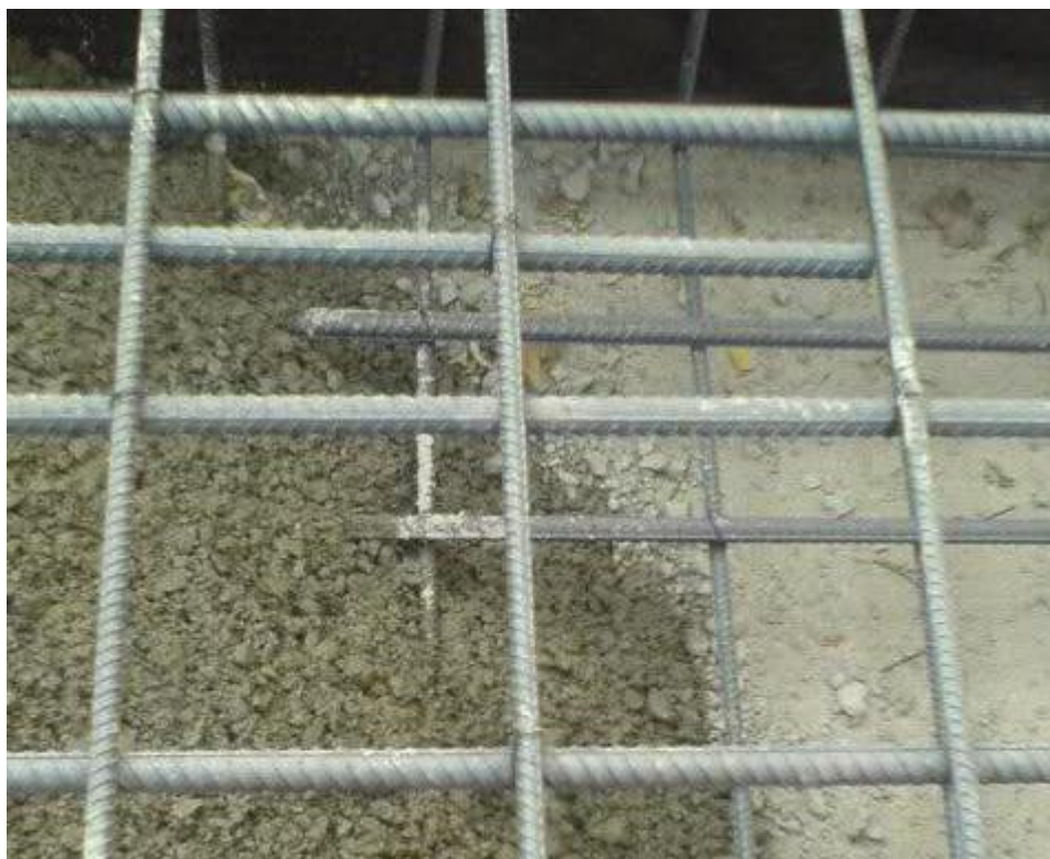
حرکت بتن میان آرماتورها.(پخش شدن بتن)
