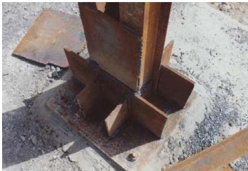
اتمام جوشکاری ستون به بیس پلیت
