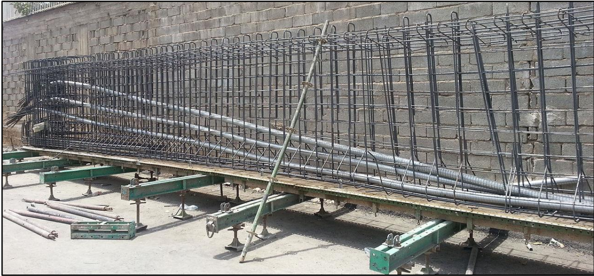
شکل ۱-۵ نمایش تیر پیش تنیده با کابل‌های چند رشته‌ای
