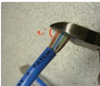
شکل ۴۵-۴- برش سیم‌های کابل شبکه
