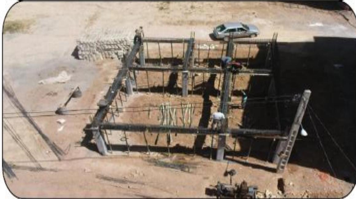
۶- گذاشتن قالب زیرین تیرها و همچنین شمع و جک تیرها و آماده نمون جهت گذاشتن تیرچه ها
