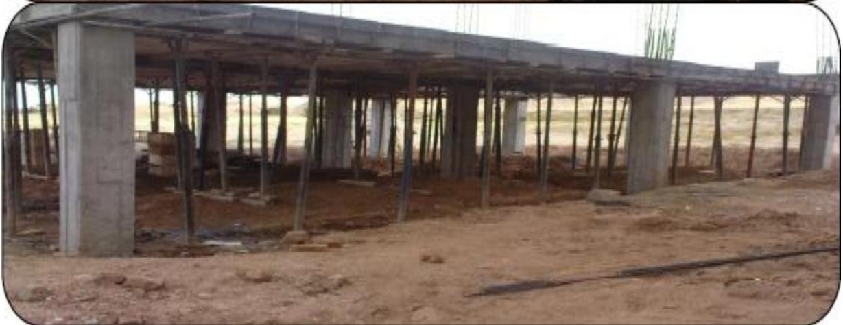
۷ گذاشتن میلگردهای حرارتی و اودکا و همچنین گذاشتن لوله‌های بخاری و خرطومهای برق در سقف و آماده کردن جهت بتن ریزی سقف و نهایتاً عمل آوری و مراقبت از بتن
