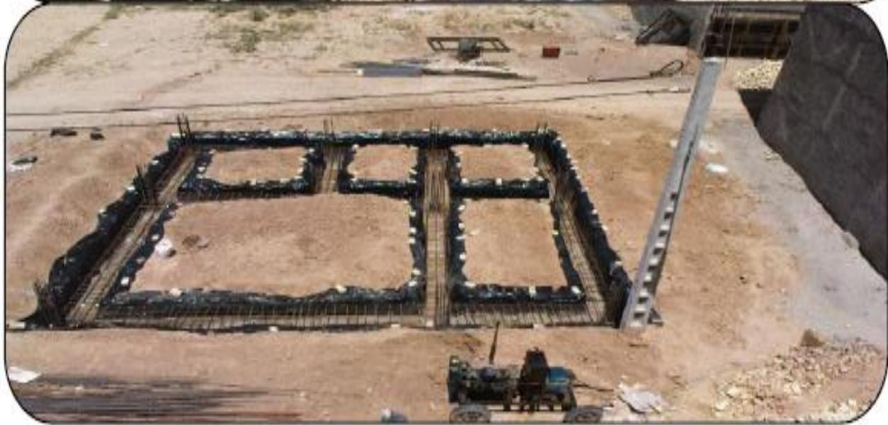
۴- بتن ریزی فونداسیون و ویبره نمون آن جهت متراکم کردن و هواگیری آن و در نهایت مربوط نگه داشتن و عمل آوری آن به مدت حد اقل دو روز جهت رسیدن به مقاومت مطلوب
