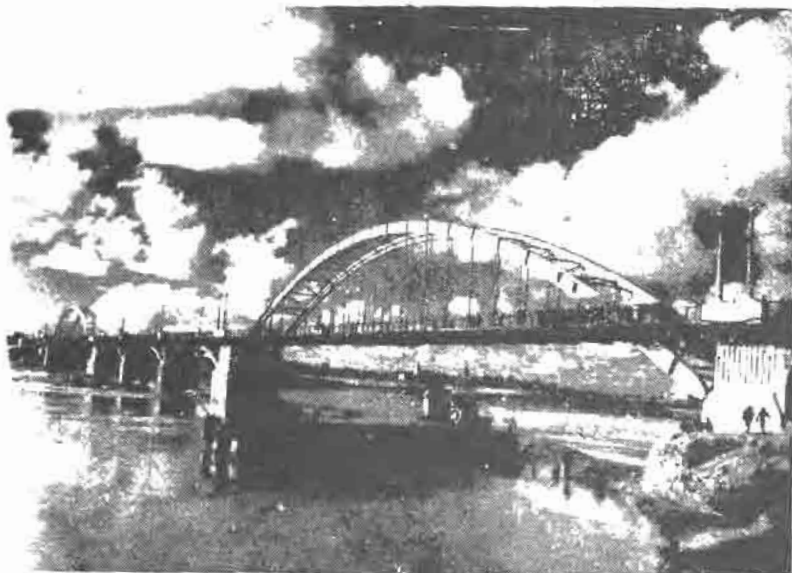
د پل فلزی اهواز»
