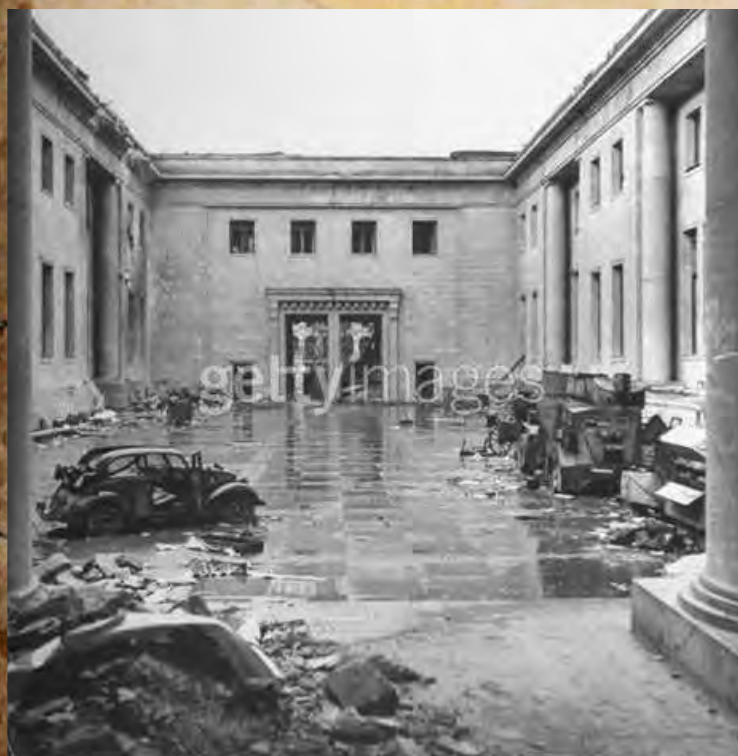
آثار تخریب در محوطه یکی از ساختمان های کاخ صدارت عظمی در برلین
