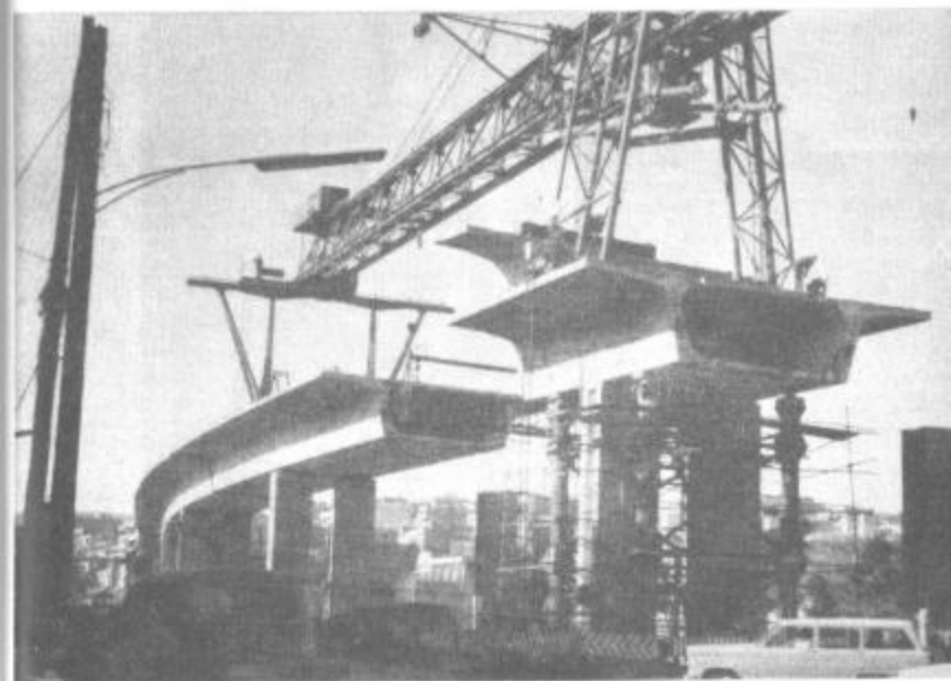
شکل (۱۶-۱) پل پیش تنیده سید خندان در حال ساخت
