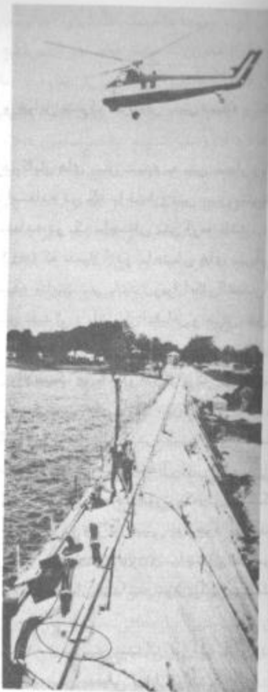
شکل (۱۹-۱) تقویت سد میلون توسط کابل های پیش تنیدگی
