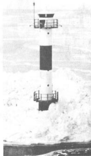
شکل (۱۸-۱) چراغ دریائی در نزدیک سواحل بالتیک سوئد که توسط کابل پیش تنیدگی به کف دریا اتصال داده شده
