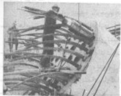
شکل (۲۰-۱) تکیهگاه کابل های پل معلق دنت
