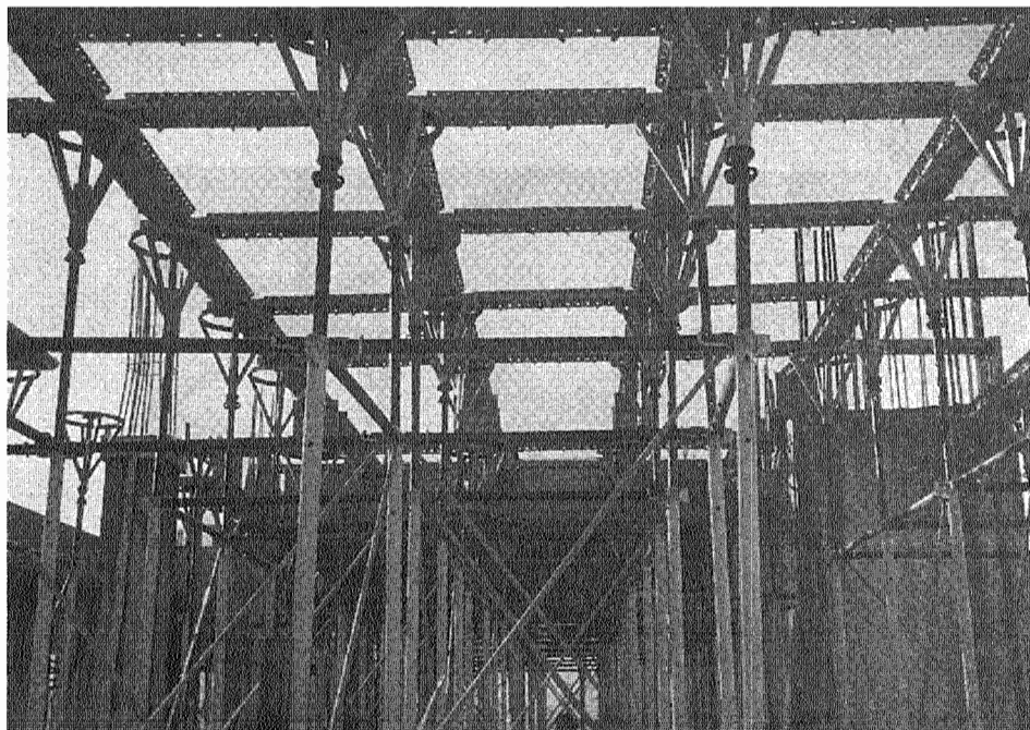
شکل ۸-۱۴ قالب تیر پس از نصب آماده نصب قالب سقف.
