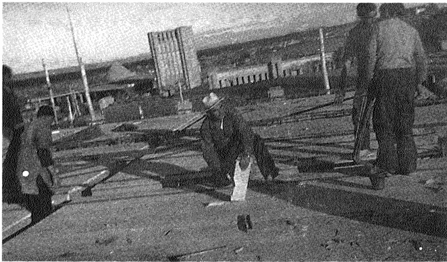
شکل ۱-۲ قالب بندی سنتی با چوب.
