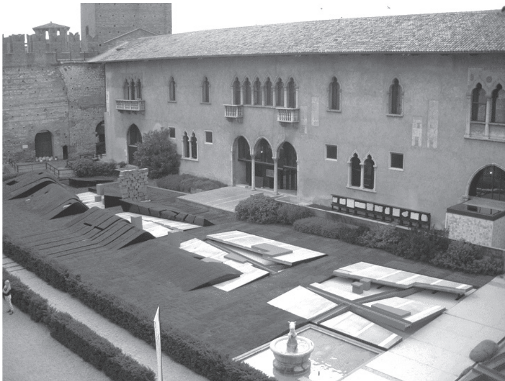
طرح اجرا شده در کستل وچیو
