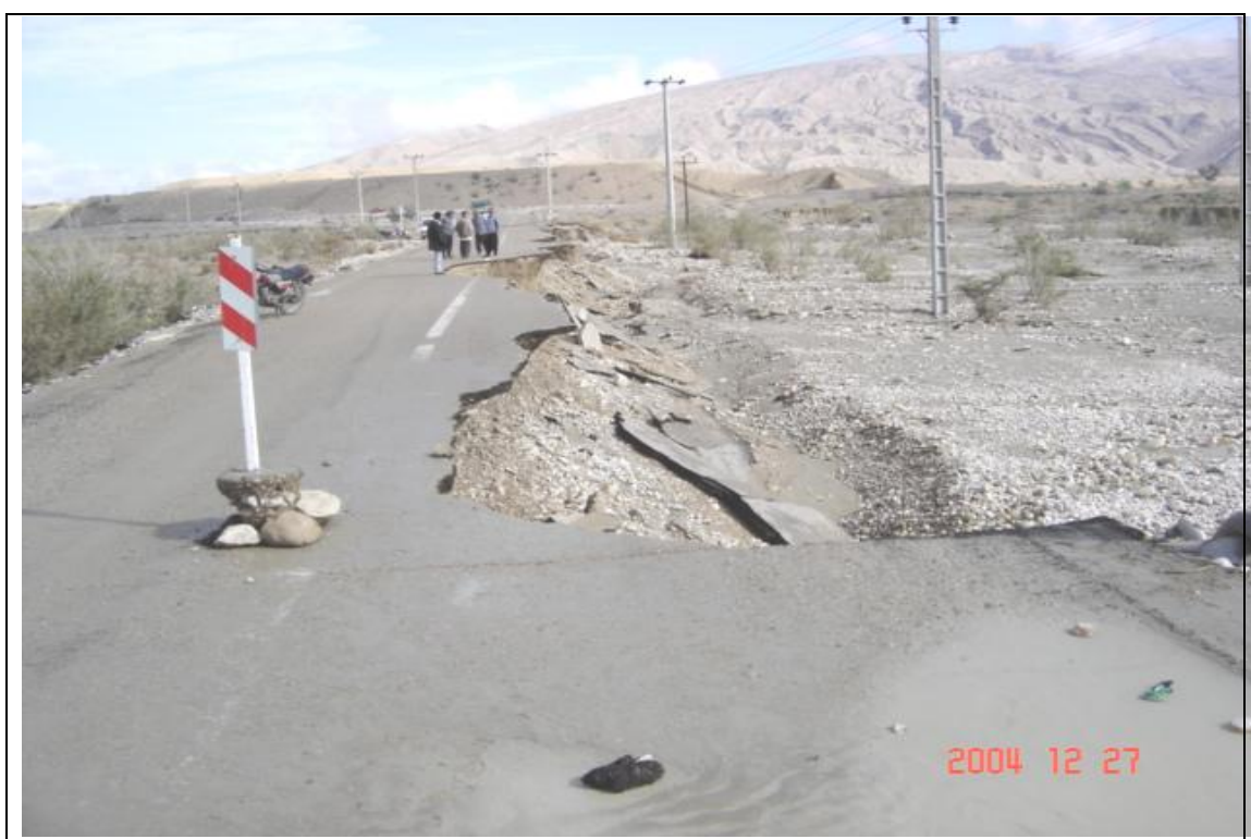
شکل 1-6- آبستگي تا نزديكي محور راه پيش رفته است
