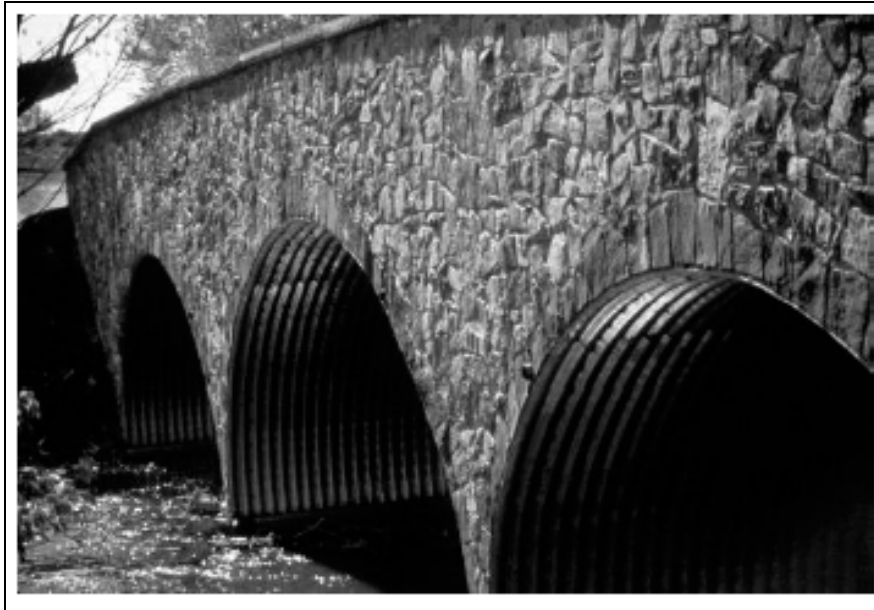
شکل 3-4 آبروهای فلزی دایره ای شیاردار
