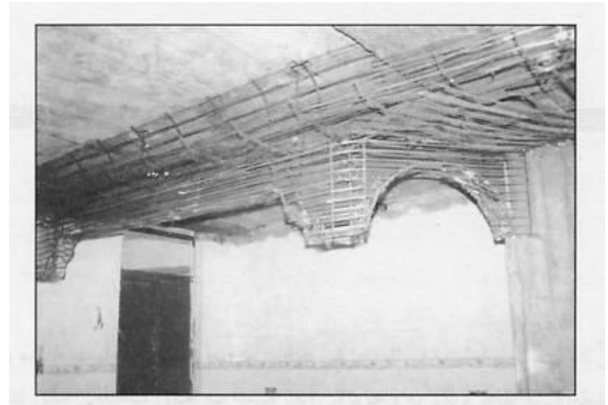
شکل ۷-۶: کلاف شبکه بندی سپری برای اجرای سقف کاذب
