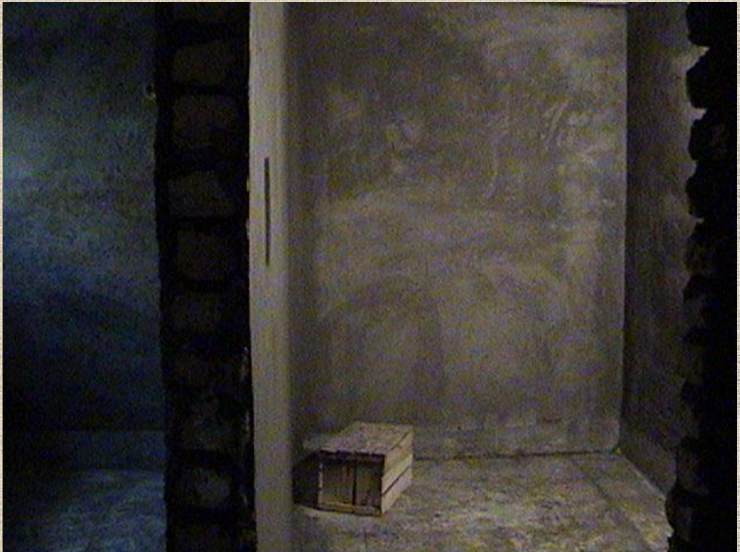
نمونه کارگاه پرورش قارچ صدفی در حال احداث
