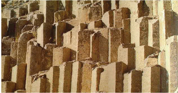
شکل ۳-۱۱: درزه‌های موجود در سنگ‌ها
