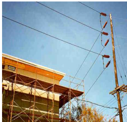
شکل ۱۴- نمونه هایی از نصب غیر ایمن داربست در کنار خطوط برق
