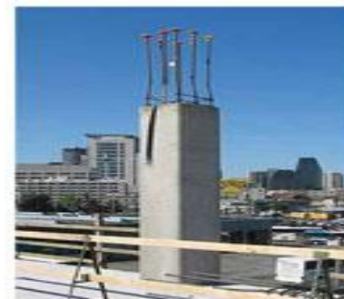
استفاده از بتن پیشرفته - قالبهای با کیفیت بالا و روش های اجرایی مناسب سبب می شود - بتنی با سطح صاف و یکپارچه به دست آید .
