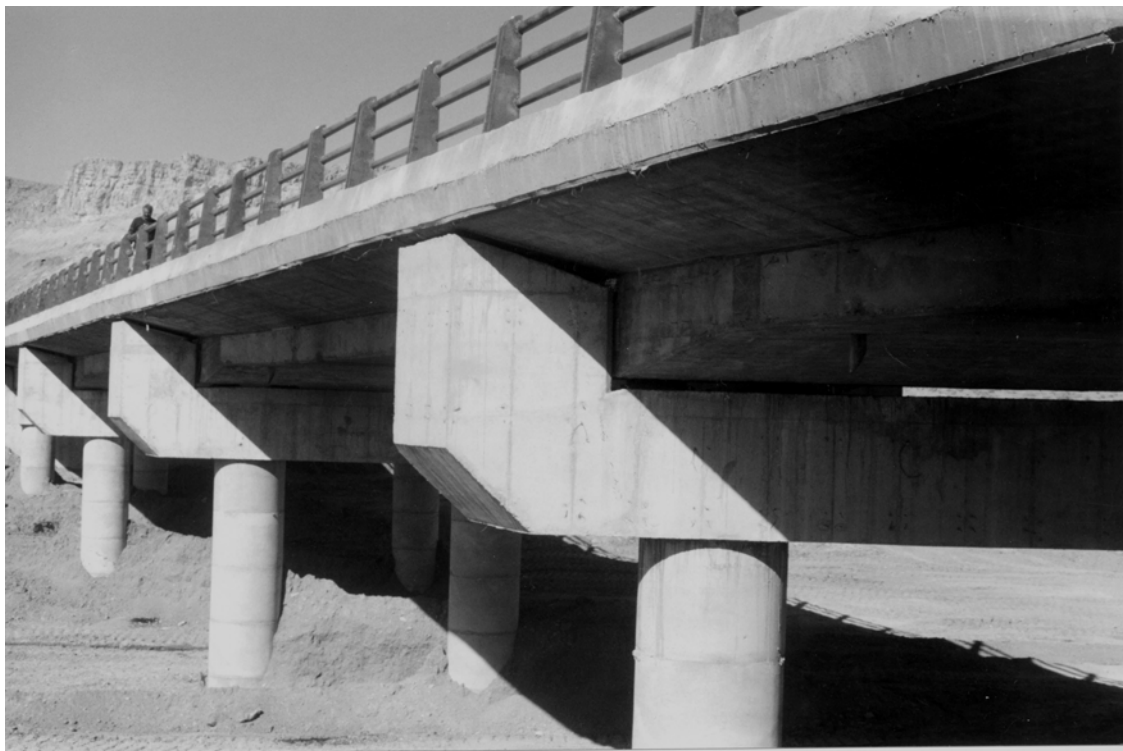
پل هستیجان یک
