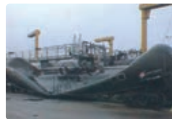
شکل ۴-۴۲ سرد شدن هوای درون مخزن باعث کاهش فشار این هوا و در نتیجه مجاله شدن مخزن شده است.
