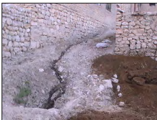
شکل (۶): آبهای جاری و فاضلاب منازل در داخل کوچه ها رها شده در داخل خاک نفوذ می کند و باعث تشدید زمین لغزش می شود
