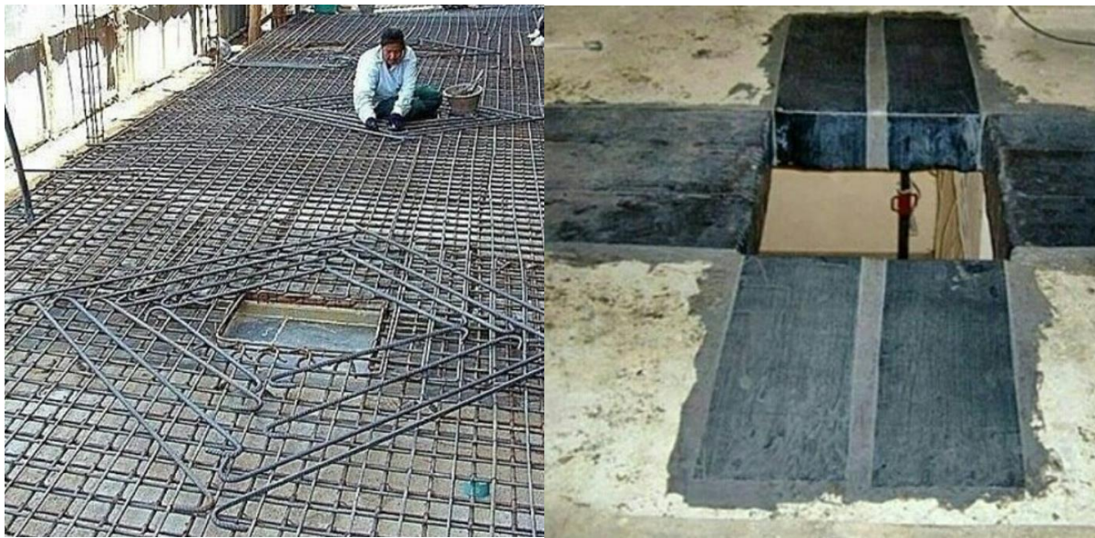
13 کاور در چشمه اتصال رعایت نشده
