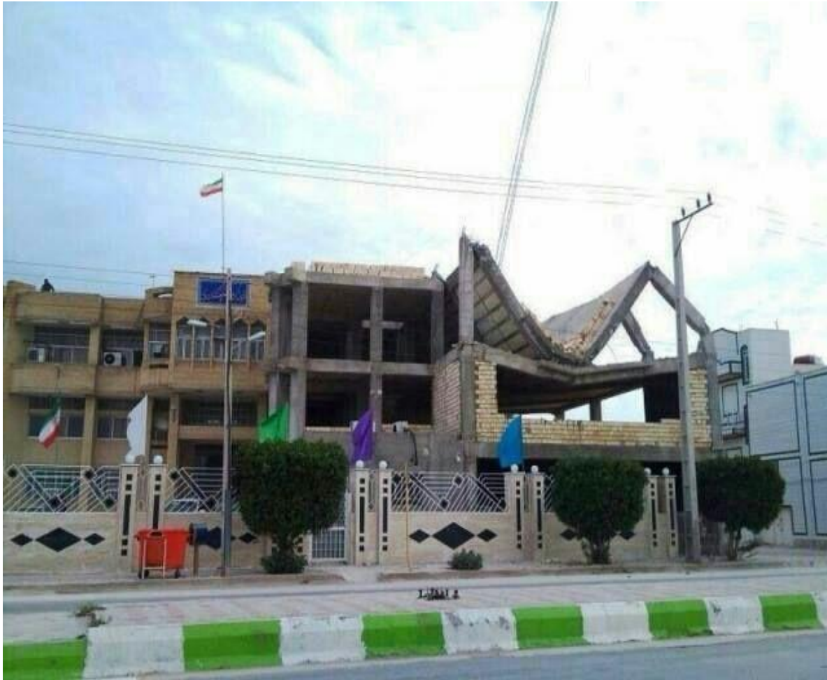
18 اتصال کابلی دال پله روشی کاملاً اشتباه .
