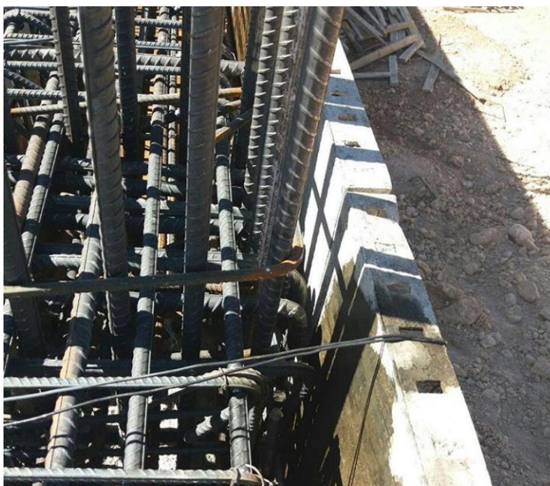
13 کاور در چشمه اتصال رعایت نشده
