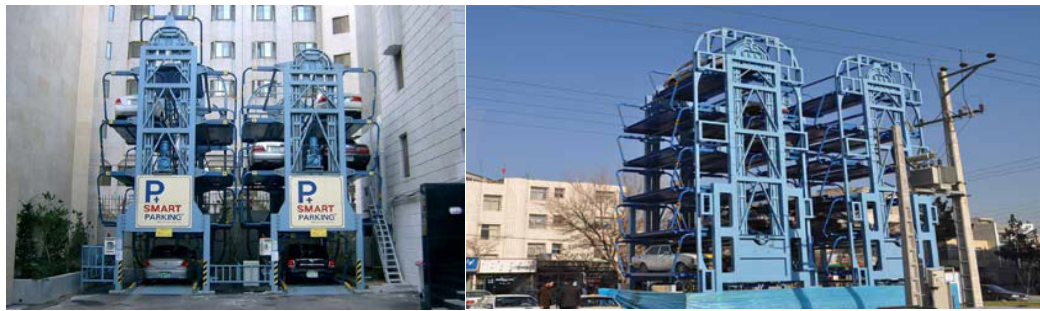
شکل ۳-۷: نمونه‌ای از پارکینگ‌های مکانیکی (مکانیزه)
