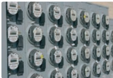
شکل ۳-۲۴- کنتور برق برای اندازه‌گیری انرژی الکتریکی مصرفی به کار می‌رود.
