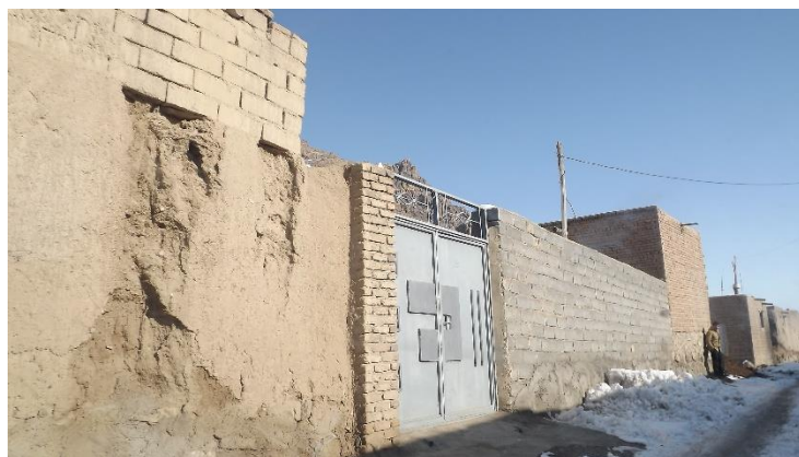
اجرای مصالح آجری در بافت جدید به همراه بافت سنتی اجرا شده با کاهگل در خانه های قدیمی گسترش یافته
