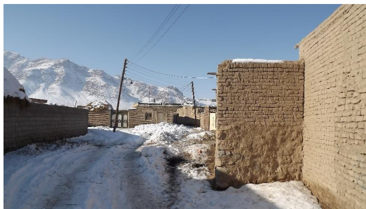
استفاده از کاهگل در پایه و ادامه ساخت با استفاده از آجر
