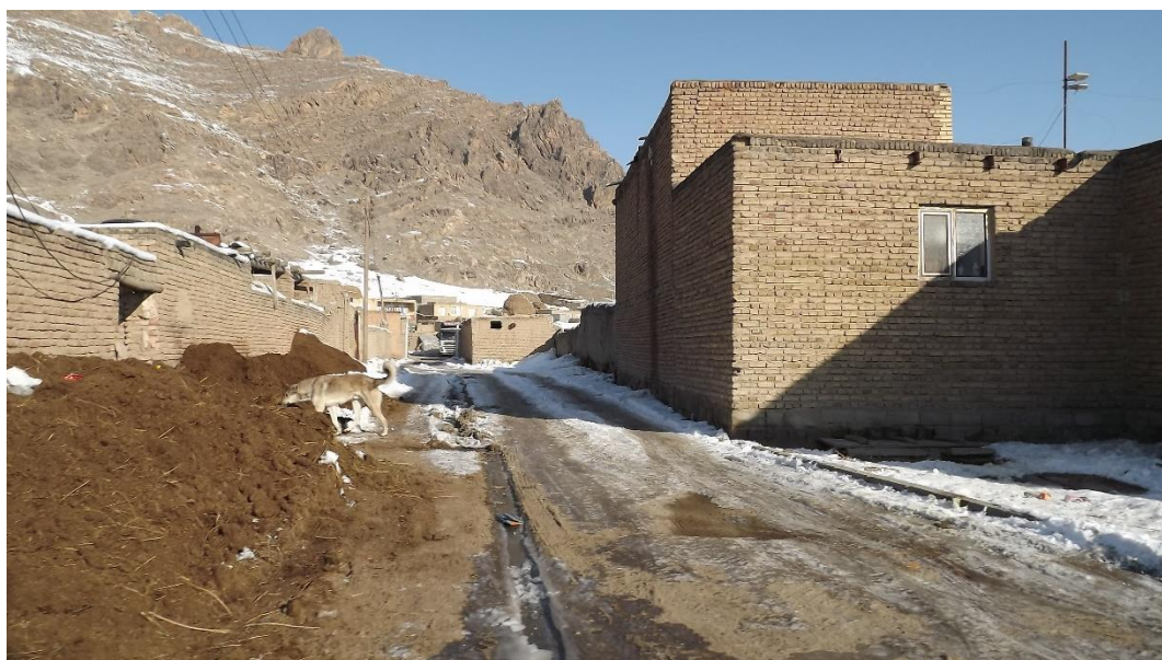
در معابر اصلی درجه دو و سایر معابر فرعی جدول کشی وجود ندارد و فقط در قسمت‌هایی از معابر به صورت مختصر و به طول چند متر آبراهه ایجاد شده است. آسفالت کشی فقط در معبر اصلی درجه یک صورت گرفته و در سایر معابر وجود ندارد.
