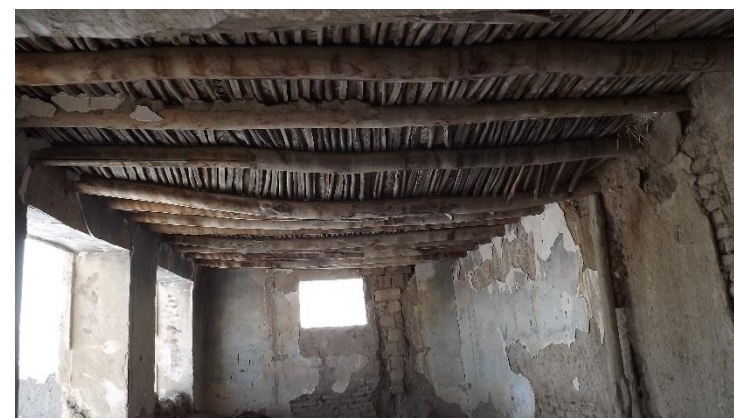
استفاده از تیر چوبی در ساختمان ها قدیمی که در ساختمان ها جدید هم استفاده می شود
