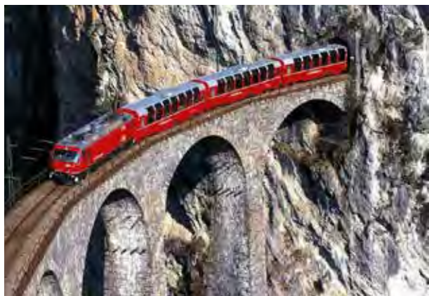
احداث تونل و ریل قطار در ناحیه کوهستانی و برفگیر سوئیس
