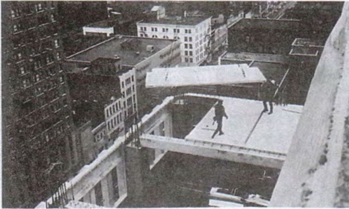
شکل ۳۳ - ۲۱ - نصب دال‌های پیش‌ساخته پیش‌تنیده بر روی تیرهای پیش‌ساخته در اجرای یک ساختمان اداری ۳۰ طبقه.
