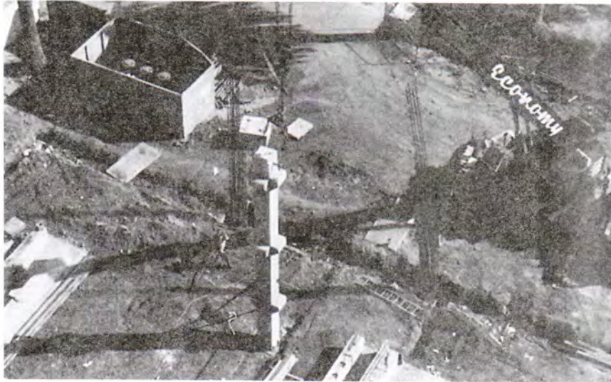
شکل ۳۳ - ۲۳ - جابه‌جایی ستون پیش‌ساخته.
