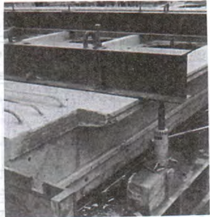
شکل ۳۳-۸ - پشت بند و جک که بیرون آوردن قطعه از داخل قالب به کار می روند.
