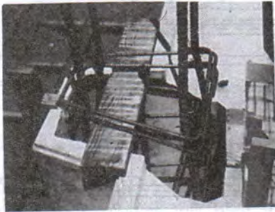
شکل ۳۳-۹ - پانل پیش ساخته در محل ستون اتصال درز.
