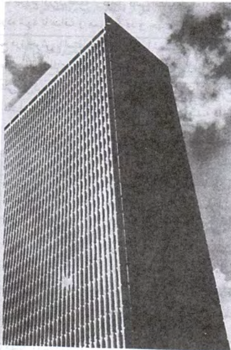
شکل ۳۳-۵ - دیوارهای بیرونی این ساختمان از پانل‌های پیش‌ساخته که در شکل قبل نشان داده شده تشکیل شده‌اند.
