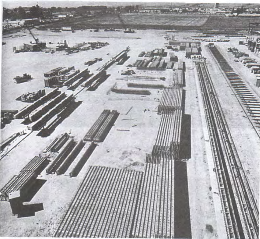
شکل ۳۳ - ۲۵ - کارگاه تولید و انبار قطعات پیش‌ساخته.
