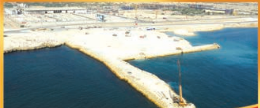
پیشروی اسکله غربی در دریا به طول ۲۷۰ متر پس از ۷ ماه از آغاز پروژه
