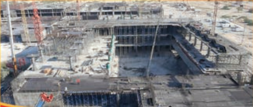
تکمیل سازه بتنی پیست پاتیناژ (اسکی روی یخ)
