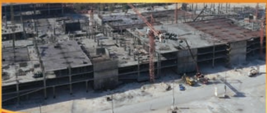
پیشرفت آرماتور بندی ، قالب بندی و بتن ریزی مرکز خرید
