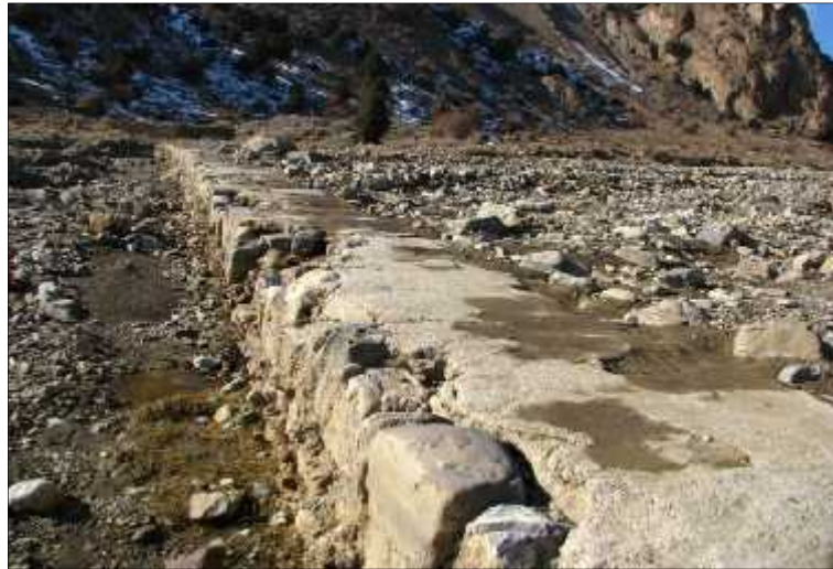
شکل (6) احداث رسوب‌گیر در بالادست سد
