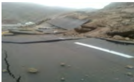
شکل ۹-۴: لغزش در ترانشه یک جاده
