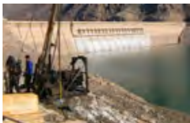
ب) دستگاه حفاری گمانه
