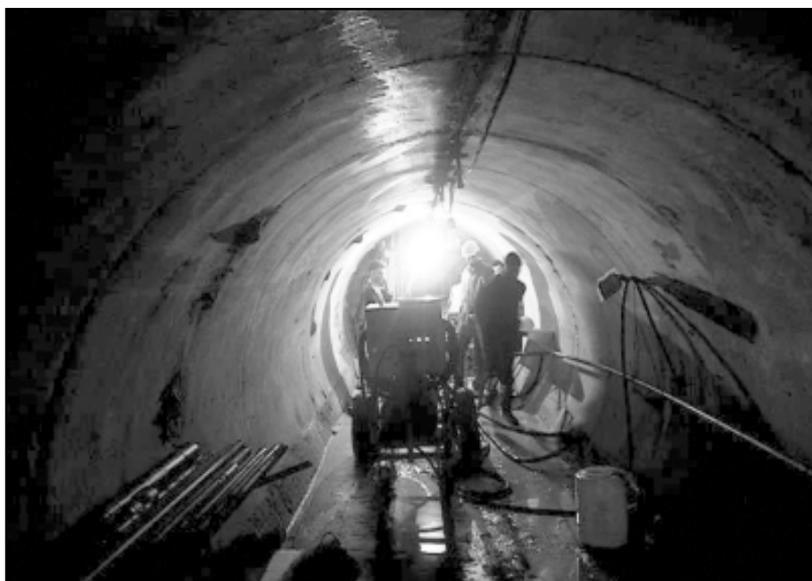
شکل ۵- ۱۳- نمایی از گالری ۶۶۰ جنوب نیروگاه
