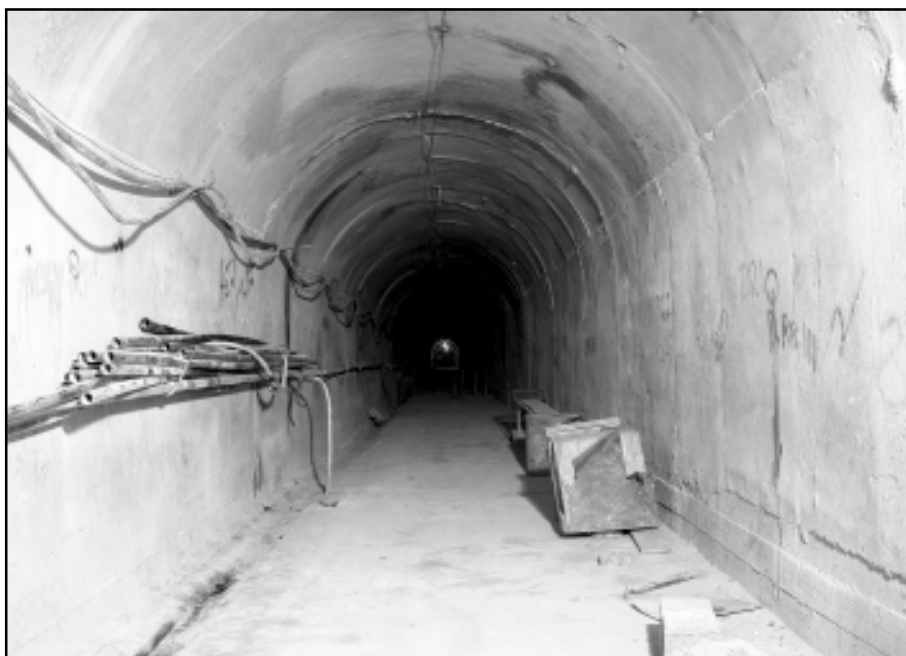
شکل ۵ - ۱۴- نمایی از گالری ۶۷۱ شرق نیروگاه
