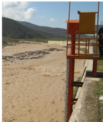
شکل ۶- نمونه‌ای از احداث لیمنوگراف از نوع لوله‌ای - ایستگاه هیدرومتری تنگراه (سمت راست) و
