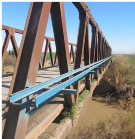
شکل ۶- نمونه‌ای از احداث لیمنوگراف از نوع لوله‌ای - ایستگاه هیدرومتری تنگراه (سمت راست) و
