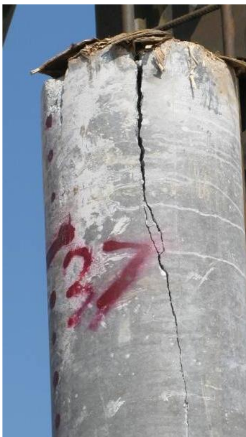
شکل الف-۲- همانطور که در تصویر سمت راست ملاحظه می گردد، افزایش بیش از حد قطر کلاهک نسبت به قطر شمع باعث شده تا کلاهک بطور مناسب بر روی شمع مستقر نگردد. این عدم تطابق منجر به ایجاد تمرکز تنش و در نتیجه شکستگی راس شمع شده است.
