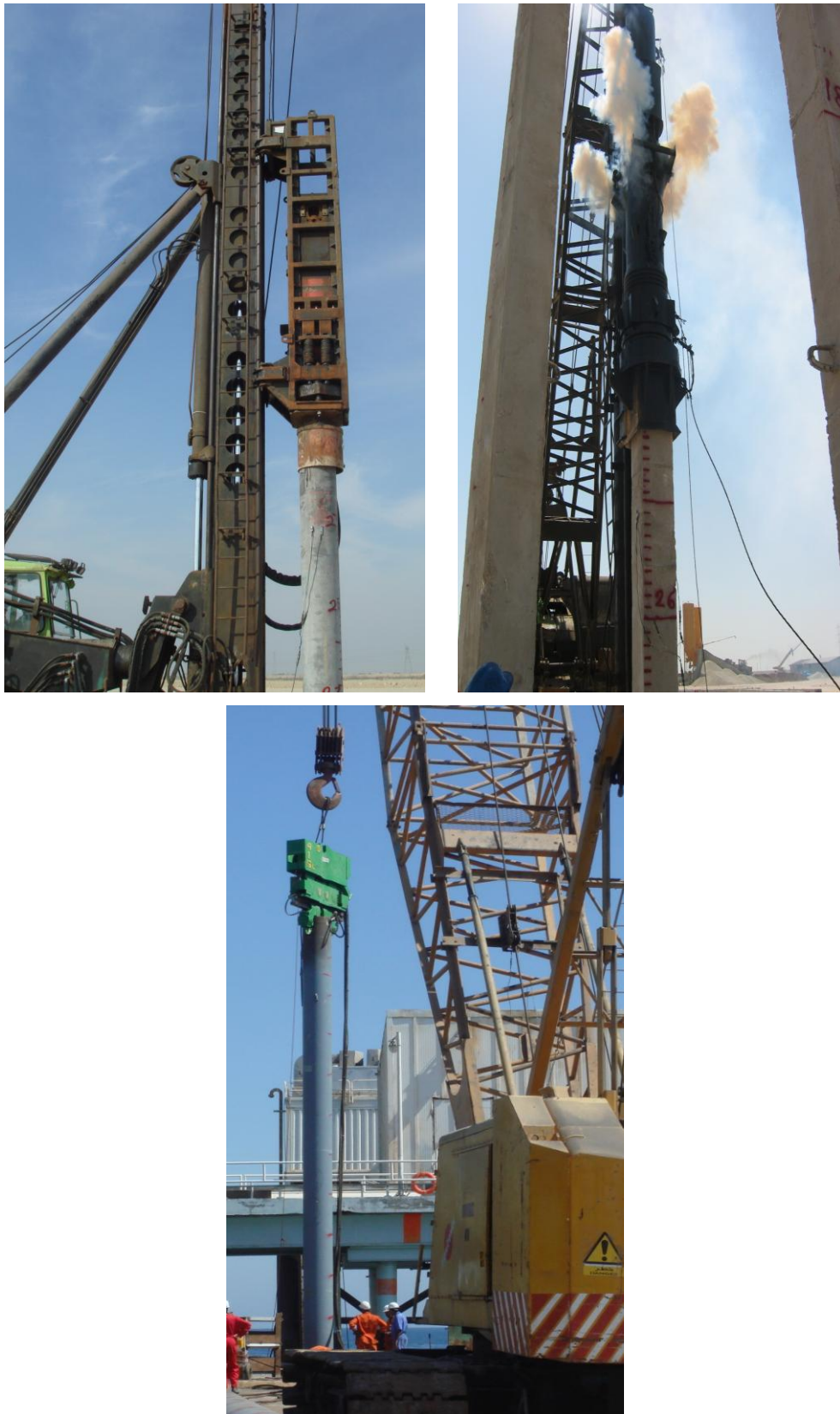
شکل الف-۱- انواع چکش‌های دیزلی (تصویر بالا راست)، هیدرولیکی (تصویر بالا چپ) و لرزاننده (تصویر پایین)
