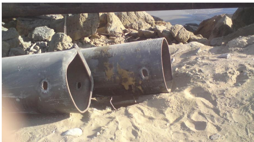
شکل الف-۱۲- آسیب دیدگی راس شمع فولادی توسط کوبش نامناسب
