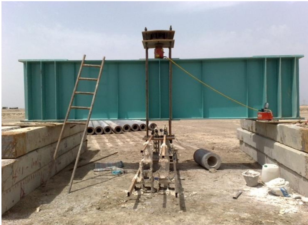
شکل الف-۲۳- تست بارگذاری استاتیکی کششی
