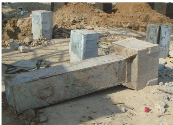
شکل الف-۴- نمونه‌ای از یک دنبالگر (Follower)
