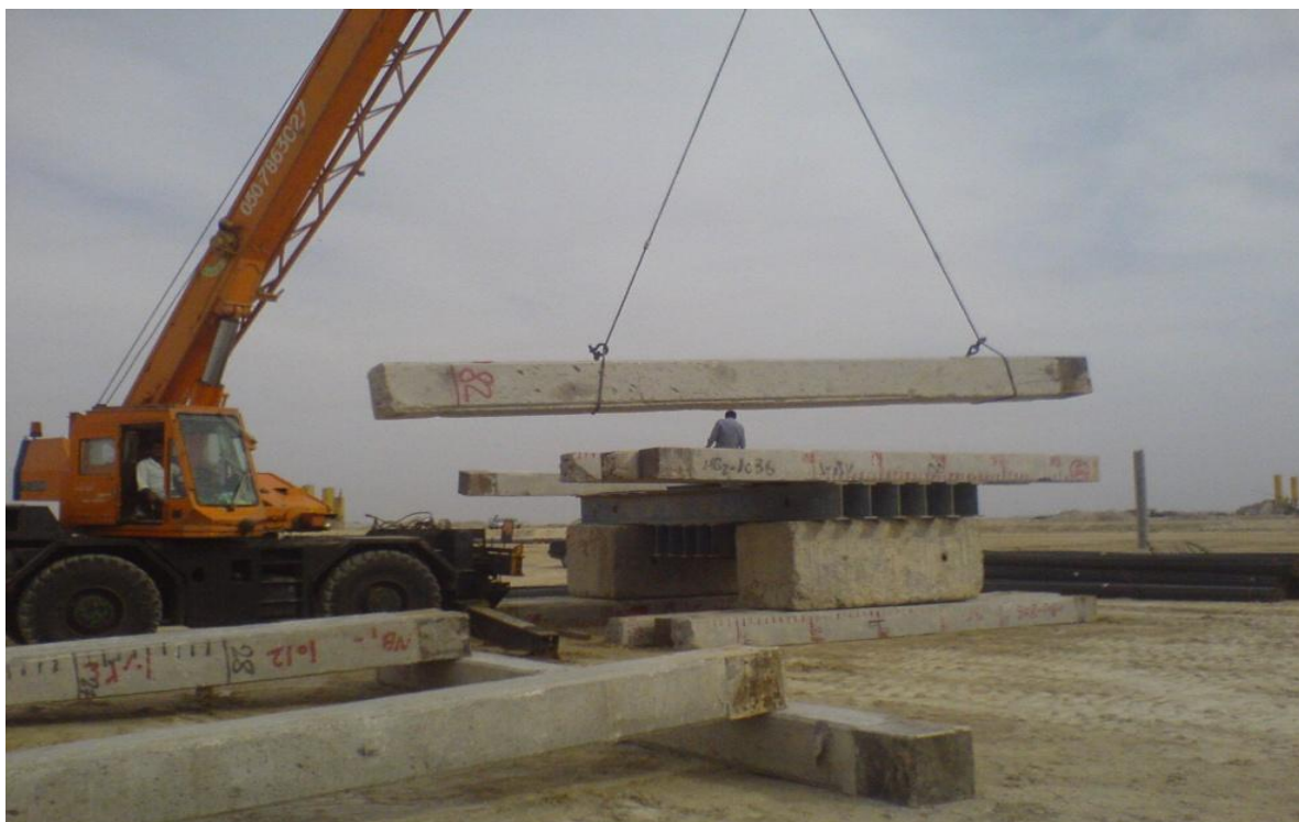
شکل الف-۶- جایجایی شمع از محل قلاب‌های تعبیه شده که کمترین لنگر ماکزیمم را ایجاد می‌نماید.
