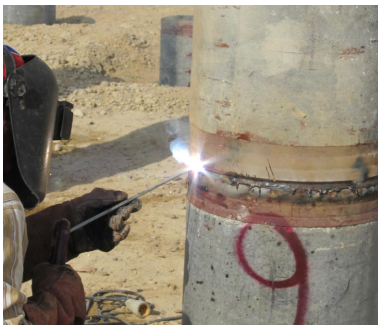
شکل الف-۷- تطویل شمع با اتصال جوشی
