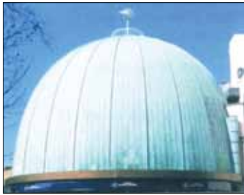
سال‌ها طول می‌کشد تا فلز مس استقرار شده در این سقف با هوا واکنش دهد.
