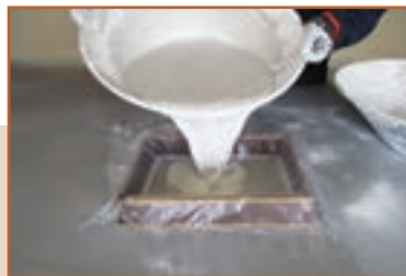
ث - ریختن ملات گچ در قالب
