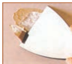
الف - باز کردن ترک‌ها
