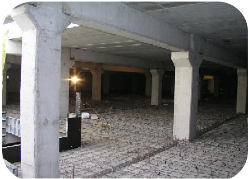
شکل ۸ اتصال ساده تیر نیمه پیش ساخته به کربل در ستون بتن مسلح پیش ساخته
