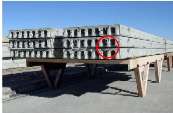
شکل ۱۹ نمونه‌ای از تعبیه فلاپ‌های حلقه‌ای شکل و کلید برشی در پانل‌های سقفی با هسته
