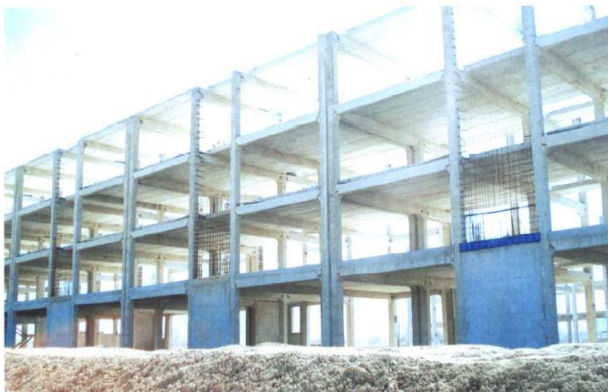
شکل ۱ قاب ساختمانی ساده بتن مسلح پیش ساخته با دیوار برشی بتن مسلح درجا
