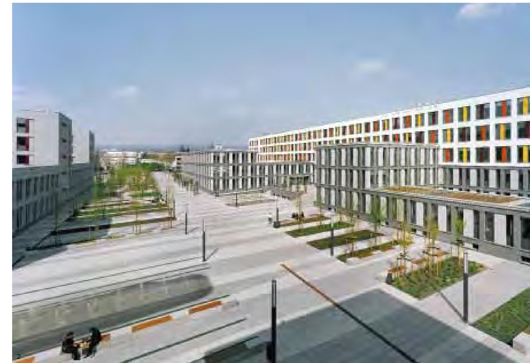
1, 2. 建筑的上层以白色灰泥墙面为主，而天井一侧的立面则运用了五彩斑斓的开窗，从而与直角形状的三层和五层建筑的灰泥墙和天然石材立面形成鲜明的视觉对比。
