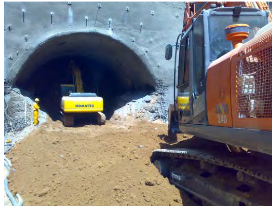
شکل (۷) حفاری هسته بنج بدون ساپرت مناسب به دلیل نداشتن درام کاتر با اندازه مناسب تونل
