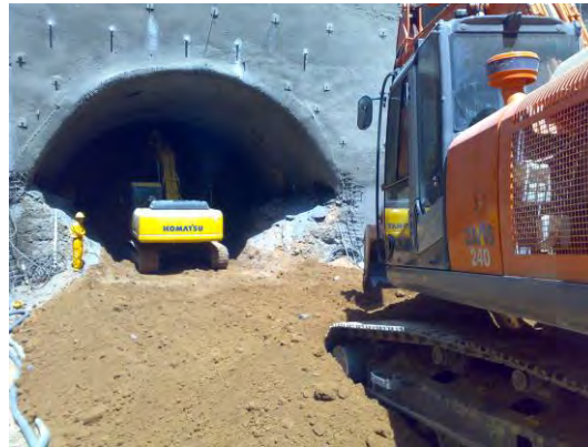
شکل (۷) حفاری هسته بنج بدون ساپرت مناسب به دلیل نداشتن درام کاتر با اندازه مناسب تونل
