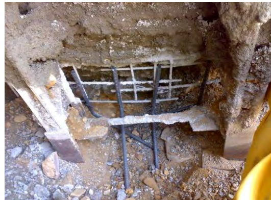
شکل (۱۳) نحوه قرار دادن میلگردهای انتظار بین دو لتیس
