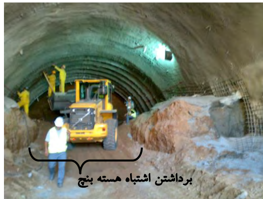
شکل (۸) مشاهده می‌شود که پیمانکار بدون رعایت مراحل صحیح حفاری، هسته بنج را کاملاً تخریب نموده است
