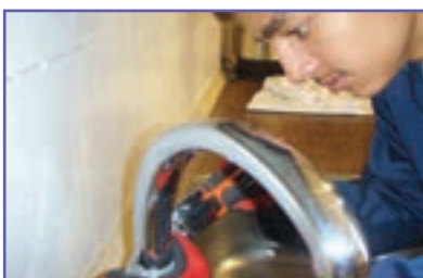
خ- سوار کردن اجزای باز شده
