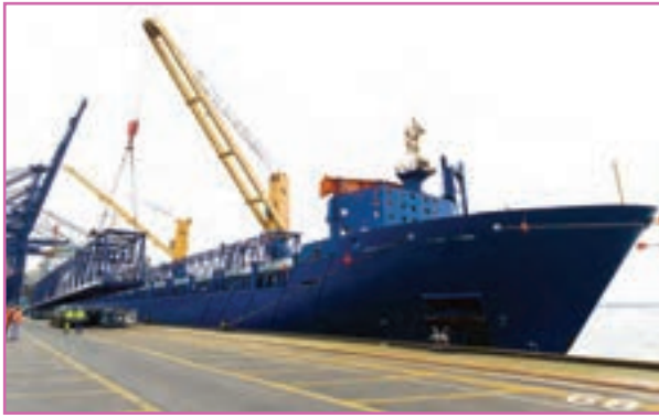
الف - نصب جرثقیل بر روی کشتی
