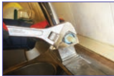
ث- باز کردن پیچ روی مغزی (گلند)
