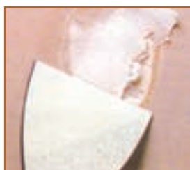
ب - لکه گیری و ترمیم ترک‌ها
