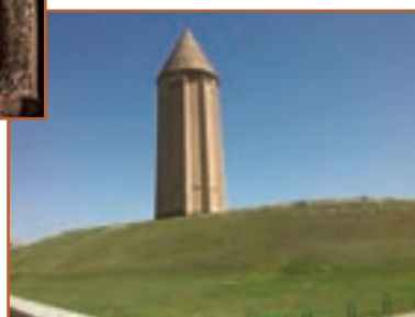
شکل ۲۷-۷- بنای گنبد قابوس، بلندترین برج آجری دنیا
