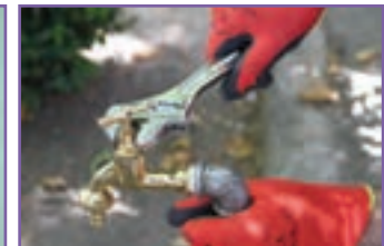
ج - بستن کلگی شیر ابتدا با دست و سپس محکم کردن آن با آچار
