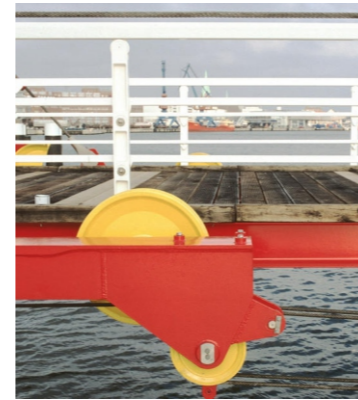
تکیه گاه محوری thrust bearing support تکیه گاه غلتکی roller support
