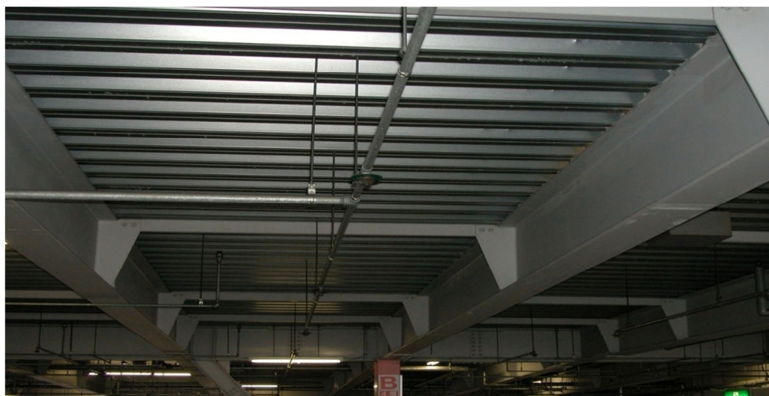
شکل (34): مهار جانبی بال پایینی تیرهای مرکب عرشه فولادی
