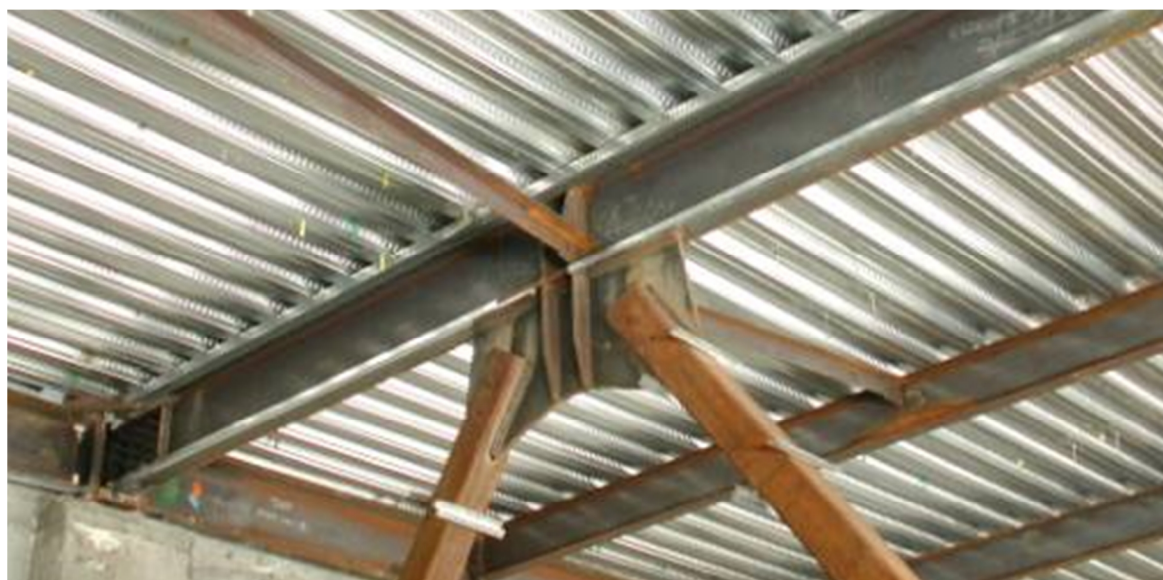
شکل (14): مهار جانبی تیر دهانه مهاربند 8
