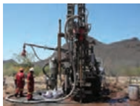
ب) دستگاه حفاری گمانه
