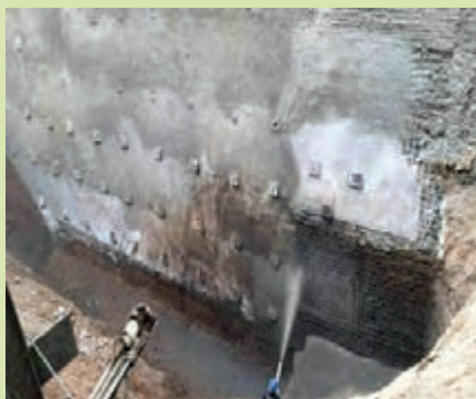
پایدارسازی شیب به روش میخ کوبی
