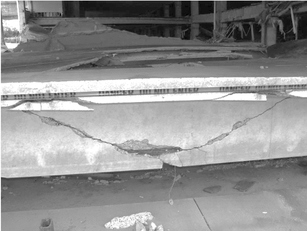
انتقال برش از طريق كشش قطرى
