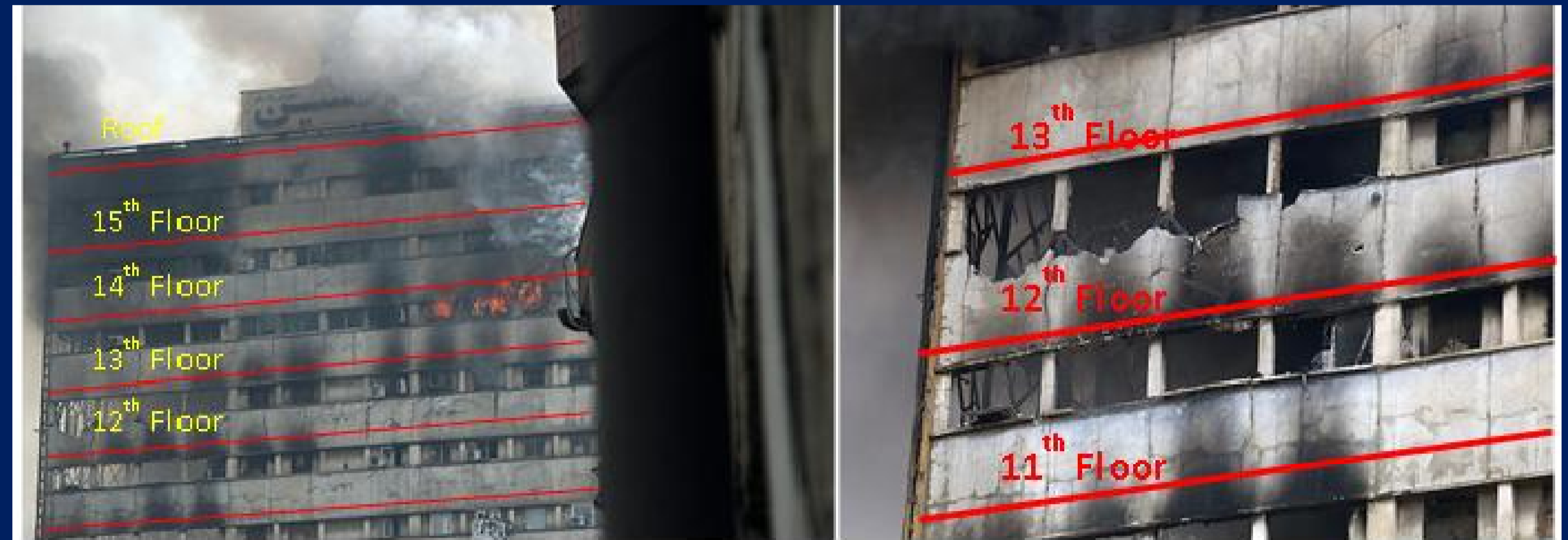
نمای نزدیک-تر ضلع غربی پس از خرابی-های مرحله اول و دوم
