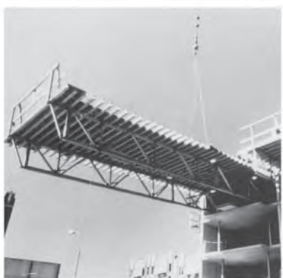
(d) Removing flying form table
