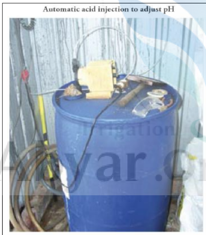
شکل (5): دستگاه تزریق خودکار اسید به آب آبیاری جهت اصلاح PH
