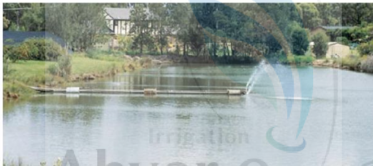
شکل (13): سیستم استخر طبیعی تصفیه رسوبات آهن همراه با هوادهی و لوله مکش شناور
