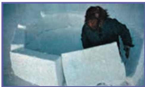
شکل ۴- الف - مراحل ساختن یک ایگلو
