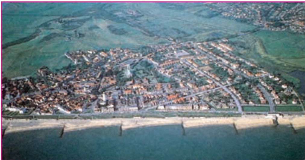
شکل ۷- احداث حفاظ در سواحل ماسه‌ای
