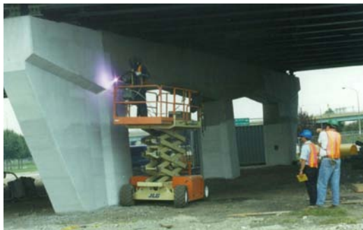
شکل ۶: اعمال سیستم آلیاژ قربانی شونده آلومینیوم - روی - ایندیوم بر روی پایه پلی واقع در امتداد ساحل خلیج تگزاس
