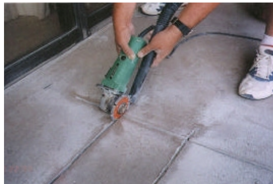
شکل ۴: ایجاد شیار در سطح فوقانی یک بالکن آپارتمانی
