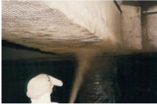
شکل ۳: شبکه آند تیتانیومی که بر روی آن یک لایه روکش اجرا می‌شود
