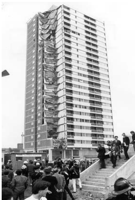
شکل ۱-۲: خرابی ساختمان رونان [2].
