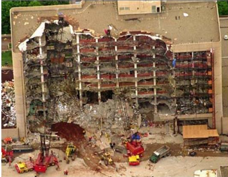
شکل ۱-۳: خرابی ساختمان مورا [3].
