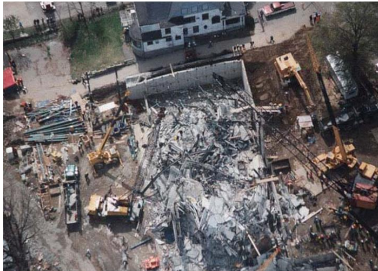
شکل ۱-۵: خرابی ساختمان Ambiance Plaza ناشی از خطای اجرایی [5].
