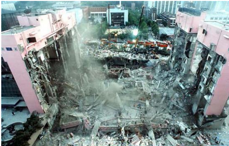
شکل ۱-۴: خرابی ساختمان Sampooing department store ناشی از خطای طراحی [5].
